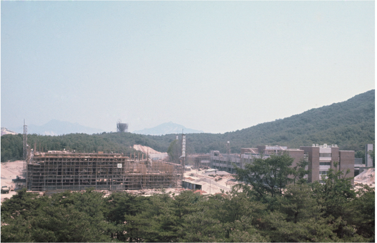
1969 건설 중인 본관 모습
