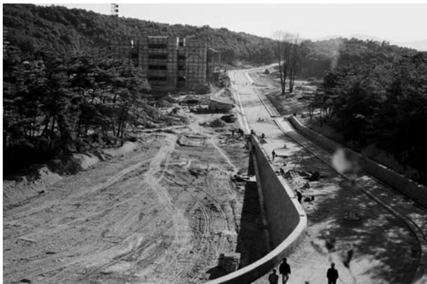
1968 KIST 건설 공사 모습(L5 예정지 환상도로)
